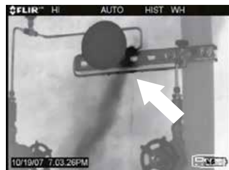
圧力計のガス漏れ
