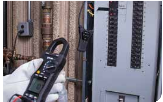
FLIR TA74 المستخدمة بشكل متوافق مع المقياس المشبكي FLIR CM83
