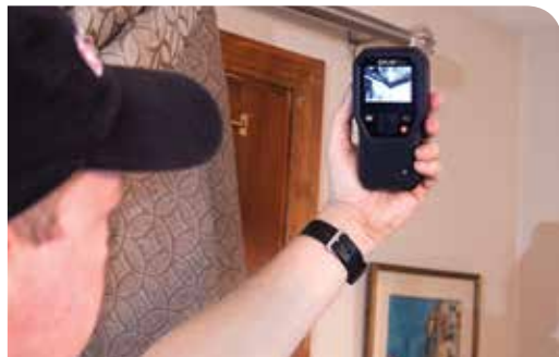
FLIR MR160 podczas skanowania połączeń ścian z sufitem w celu wykrycia problemów z wilgocią.
