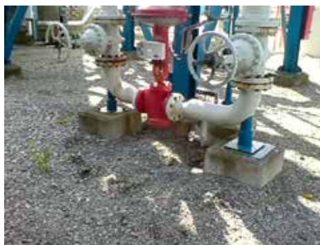
Aus diesem Ventil entweicht Ethylen. Im Wärmebild mit der Einstellung 'schwarz-heiß' ist es daher als weißer Rauch zu erkennen.
