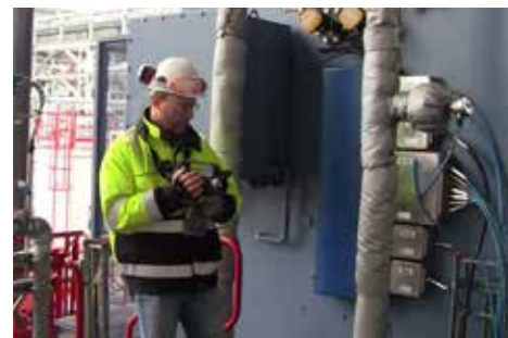
Jan Åke Schiller, der Schichtleiter LDPE, war zunächst skeptisch. Jetzt ist er jedoch von den Möglichkeiten Gase detektierender Kameras überzeugt.
