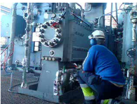
Ein Schnüffelgerät muss genau an die richtige Stelle gehalten werden, um ein Gasleck aufzuspüren. Gase detektierende Kameras können entweichende Gase an jeder Stelle innerhalb ihres Sichtfelds entdecken.
