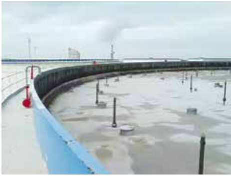
ガス探知用赤外線カメラFLIR GF320による近距離からの検査で、このタンクの周縁全体からガスが漏れていることが判明した。
