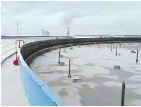
使用FLIR GF320光学气体红外热像仪进行近距离检测，发现储罐整个边缘都在泄漏。
