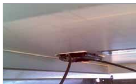
La termocamera FLIR T335 può anche essere usata per scansionare gli altri elementi dell'impianto solare, come questo connettore difettoso.
