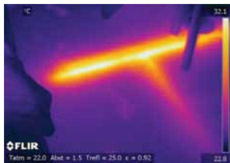
Questa immagine termica mostra dove è stato installato il tubo dell'acqua calda sotto il pavimento.
