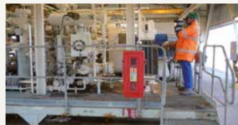
Suche nach entweichendem Erdgas mit Hilfe der Gasvisualisierungskameras der GF-Serie
