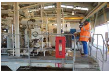
使用GasFindIR HSX检测天然气泄漏
