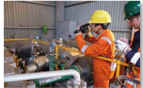
在两张图片中，GasFindIR CO一氧化碳泄漏热像仪均检测出一氧化碳泄漏。
