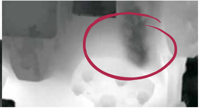
Détection d'une fuite de gaz.
