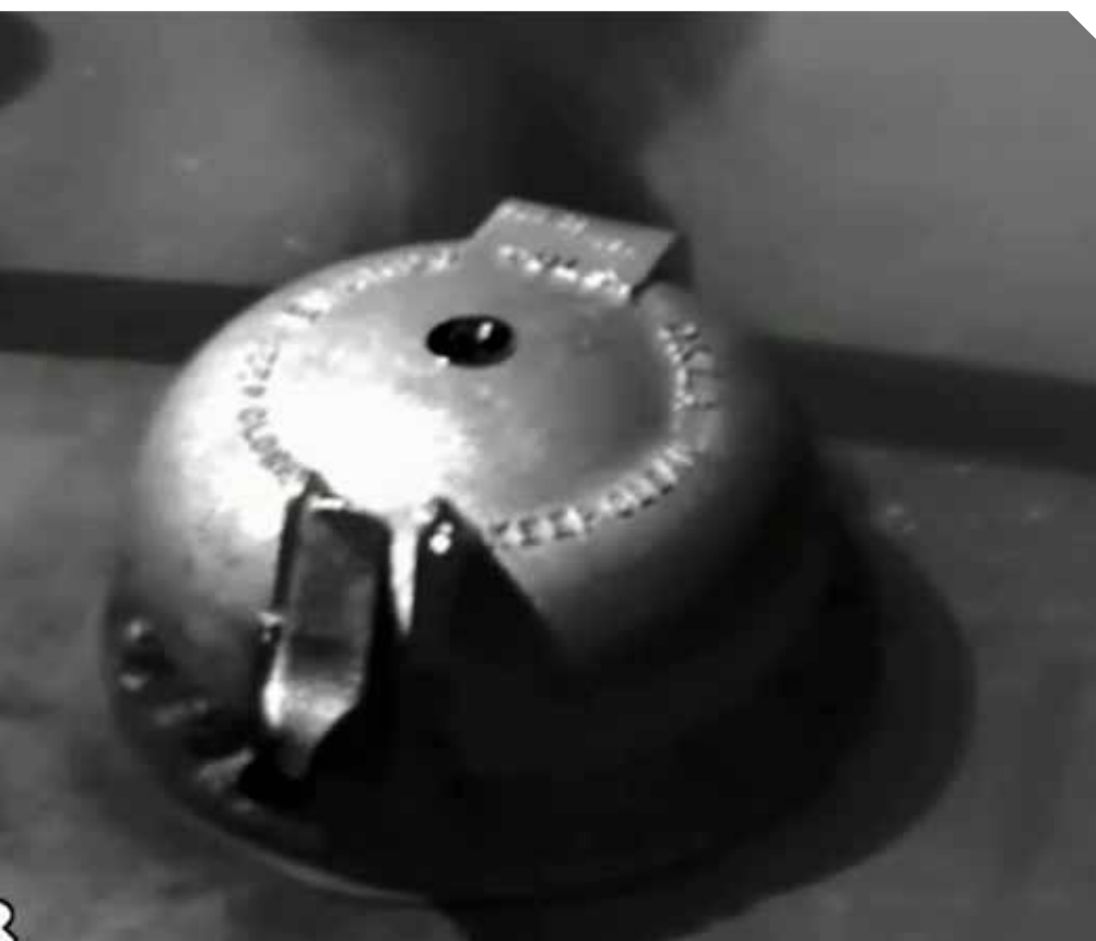
Une caméra de détection optique des gaz présente une fuite de méthane provenant d'un trou d'homme
