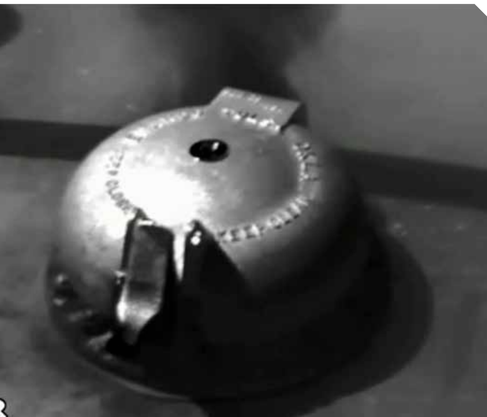
La cámara óptica de gas muestra una fuga de metano en la escotilla de muestreo.
