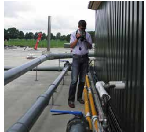
Ex-geschützte Bereiche können mit der FLIR GF320 aus sicherer Entfernung untersucht werden.
