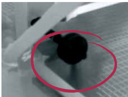
Das Gasleck lässt sich auf dem Wärmebild deutlich erkennen.
