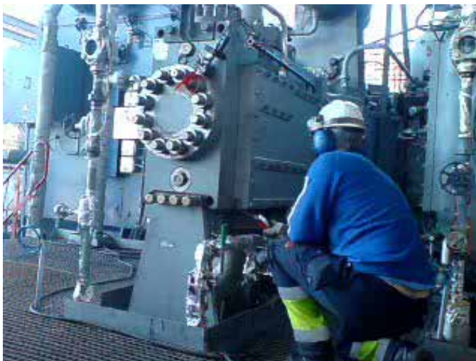
Mit dem "Sniffer" erkennt man das Leck nur wenn man ihn gerade zufällig genau davor oder dicht daneben hält. Gasdetektionskameras erkennen innerhalb ihres Sichtfelds alle vorhandenen Gaslecks
