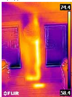
Теплая сливная труба в стене
