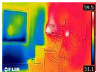
Mur extérieur non isolé
