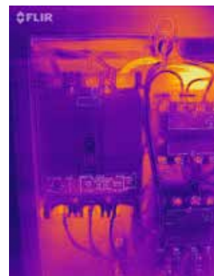
Identifica i guasti elettrici
