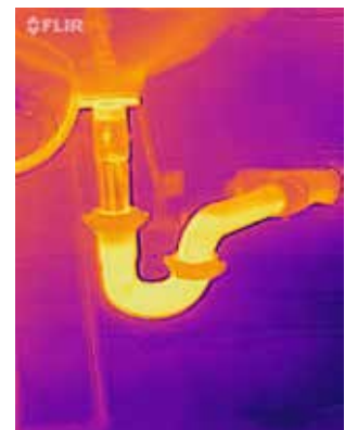
Überprüfen Sie Installationen auf Wasserlecks
