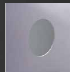
Krok 1: Vyvrtní jednoho otvoru
