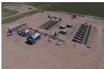
I separatori della Noble Energy a Wells Ranch Colorado sono talmente ravvicinati tra loro che i tecnici hanno bisogno di una termocamera a Sicurezza Intrinseca per eseguire il programma di manutenzione preventiva per la misurazione della sabbia.
