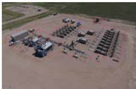
Die Abscheider auf der Wells Ranch von Noble Energy im US-Bundesstaat Colorado stehen so dicht beieinander, dass die Ingenieure eine eigensichere Infrarotkamera benötigen, um die Sandfüllstandsmessungen im Rahmen ihres präventiven Wartungsprogramms auszuführen.
