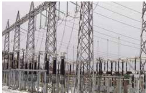
Vier A310 Wärmebildkameras überwachen kritische Komponenten innerhalb der Trafostation. Sobald an irgendeiner Stelle im Sichtfeld der Kamera die Temperatur einen vorab festgelegten Schwellwert überschreitet, wird ein Alarm abgesetzt.
