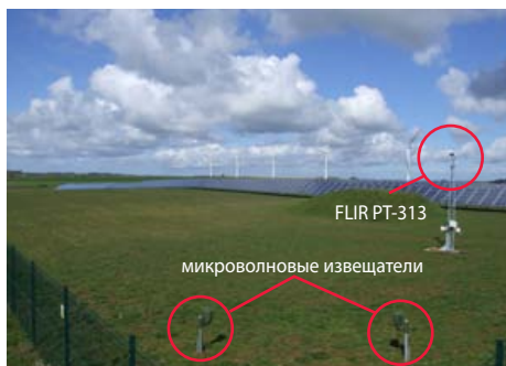
Нарушитель периметра, пытающийся преодолеть ограждение, инициирует срабатывание микроволнового извещателя. Видео в режиме реального времени, поступающее от тепловизионной камеры, позволяет персоналу поста наблюдения оперативно оценивать ситуацию.
