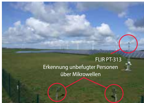
Ein Eindringling, der über den Zaun klettert, löst das Mikrowellen-System zur Erkennung unbefugter Personen aus. Anhand der Live-Wärmebild-Videoaufnahmen des FLIR PT-313 Wärmebildkamerasystems können die Mitarbeiter im Kontrollraum die Situation schnell beurteilen.
