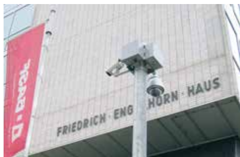
FLIR SRシリーズは敷地外周の重要なポイントに設置されている。
