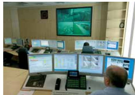
TBASFのセキュリティネットワークの中央制御室では、CCTVカメラとサーモグラフィからのすべての映像が解析されている。
