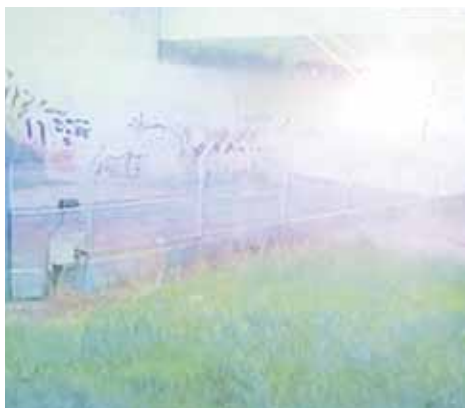
Un reflet du soleil sur la toile d'araignée située devant l'objectif aveugle totalement cette caméra de CCTV.
