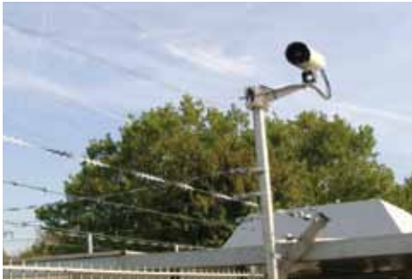
Die Wärmebildkamera FLIR SR 324 überwacht diese ganze Umzäunung.
