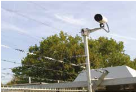
FLIR SR 324红外热像仪覆盖了护栏的整片区域。
