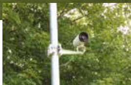
这些FLIR红外热像仪监控其中的一个洪水隐患区域。它们具有更远的侦测距离性能，可以在安全的位置远距离有效监控整个区域，且不依赖光源。
