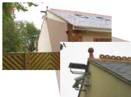
这两台FLIR SR-313红外热像仪具相近的视场角，它们共同覆盖一大片周边场地。
