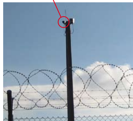
La SR-100 est montée sur un système orientable avec une caméra de CCTV. L'ensemble est installé au sommet de poteaux existants le long de la piste.
