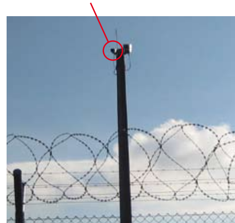
La SR-100 de FLIR Systems está montada sobre un sistema pan/tilt junto con una cámara de CCTV. El sistema se monta sobre postes existentes a lo largo de la pista.
