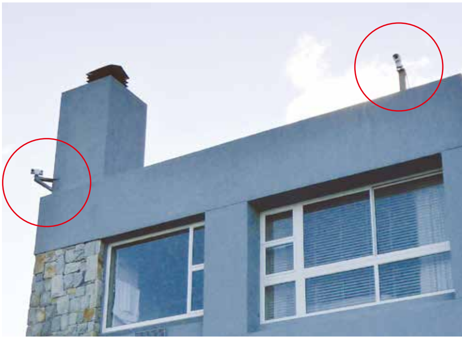
美観的な理由から、フリーシステムズの赤外線カメラの中にはマストではなくて家に取り付けられているものもあります。
