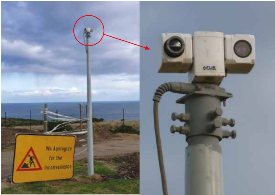
其中一台FLIR Systems的PTZ-50 MS红外热像仪俯瞰Oubaai
