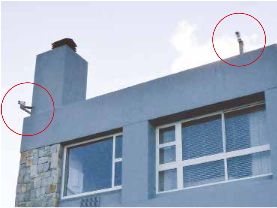
出于美观考虑，一些FLIR Systems红外热像仪安装在房子上，而不是桅杆上。
