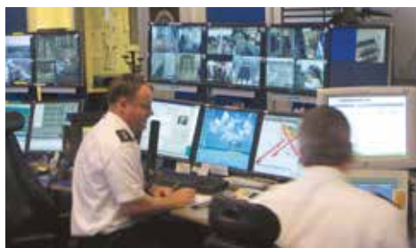
哥本哈根机场安全监控中心控制室一隅
